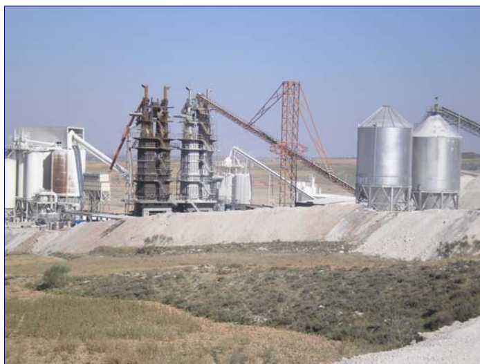
Fig. 4.20.- Fabricación de carbonato cálcico. La Puebla de Albortón (Zaragoza) BELXICAL, S.L. Arriba: Big-bags de producto a granel. Abajo: Instalación en fase de montaje.
