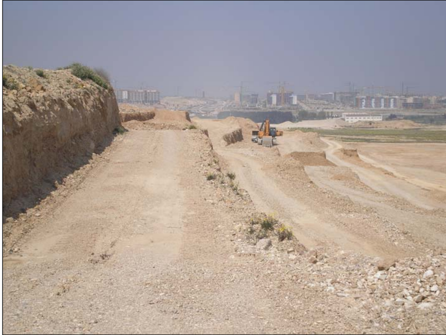
Figura 5.9.- Labores de remodelación y relleno del hueco de una explotación de áridos. Al fondo expansión urbana de la ciudad de Zaragoza
