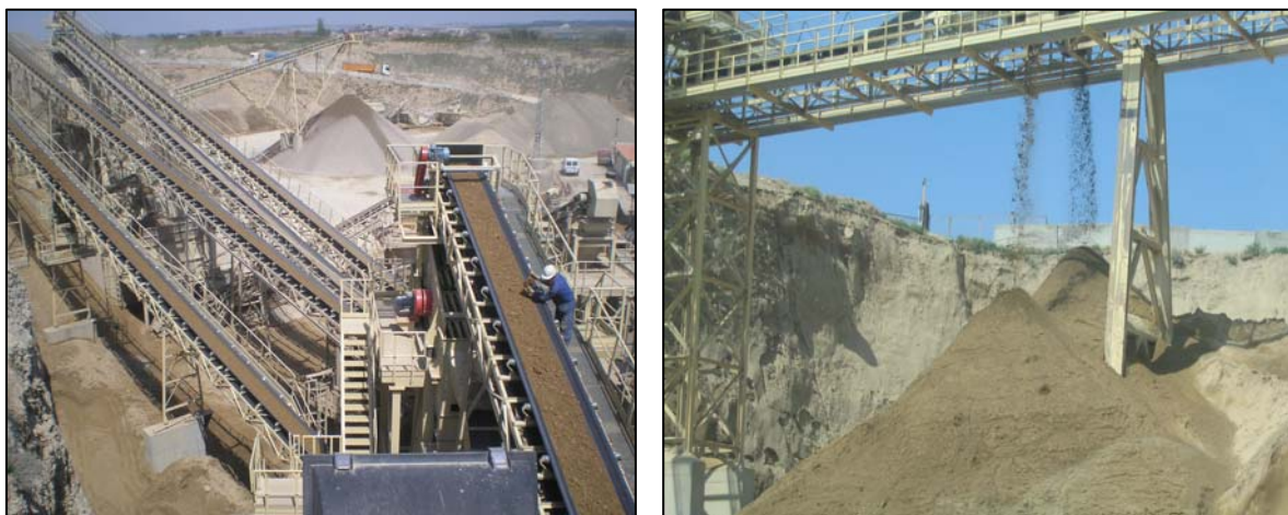
Fig. 5.24.- Planta de tratamiento en hueco de gravera (ÁRIDOS BLESA, SA.)
