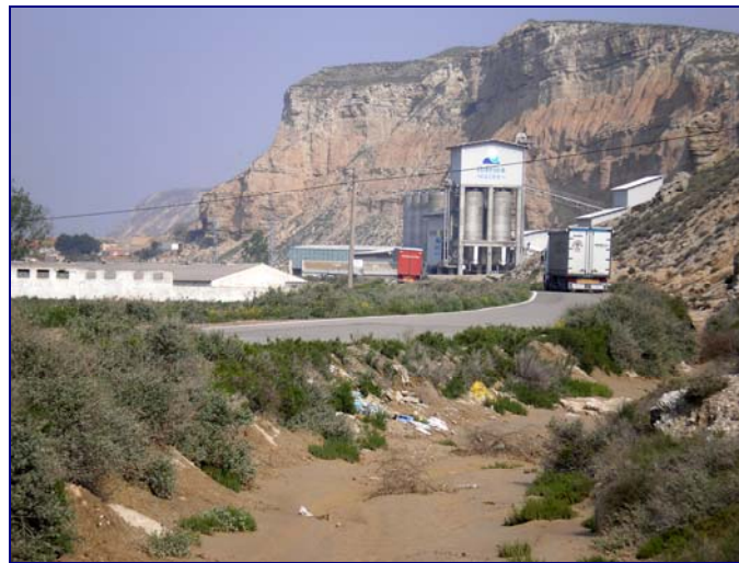
Fig. 3.13.- Planta de tratamiento de sal gema. Remolinos, Zaragoza. IBÉRICA DE SALES S.A.
