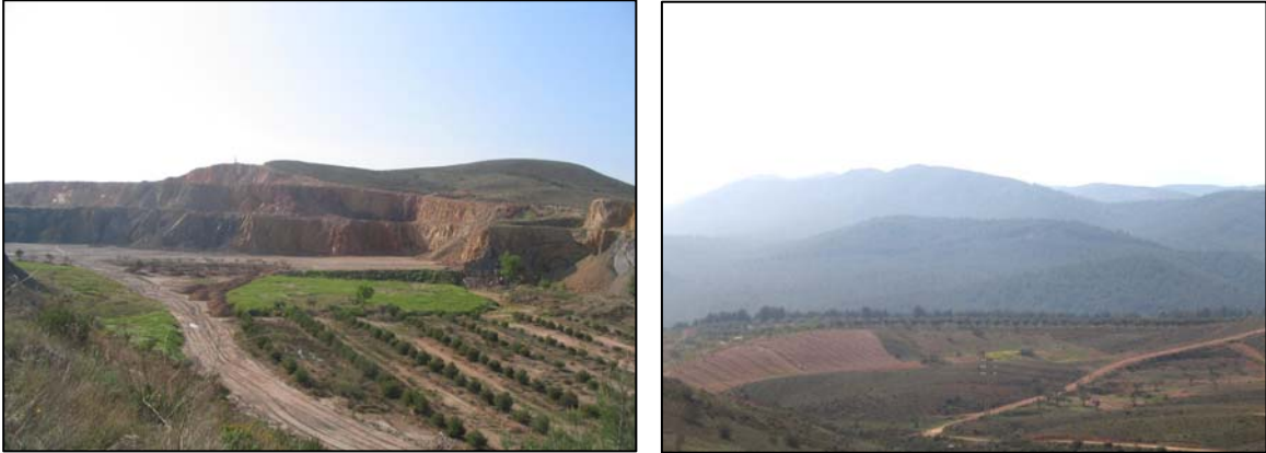
Fig. 5.48- Labores de restauración en plaza de cantera y frentes, en la explotación de caliza en Morata de Jalón, Zaragoza. CEMEX ESPAÑA, S.A.
