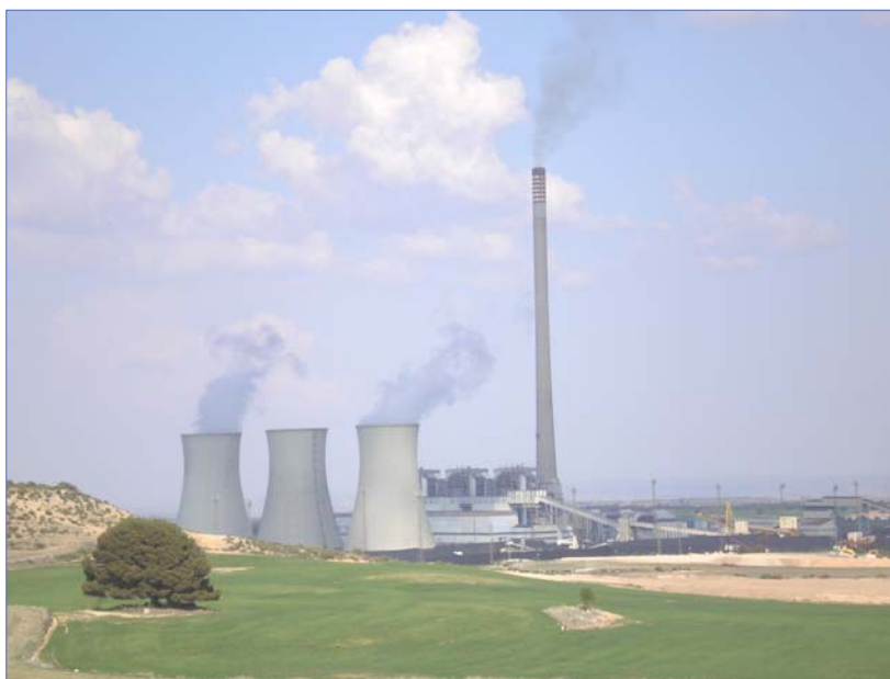
Fig. 4.21. Central Térmica de Teruel, en Andorra. ENDESA, S.A.
