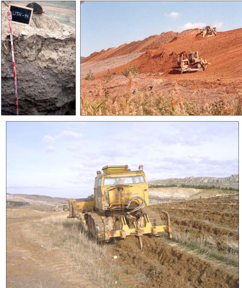
Fig. 5.30.- Suelo minero (Utrillas); extendido de la tierra vegetal y labores de descompactación (Gestión del suelo)
