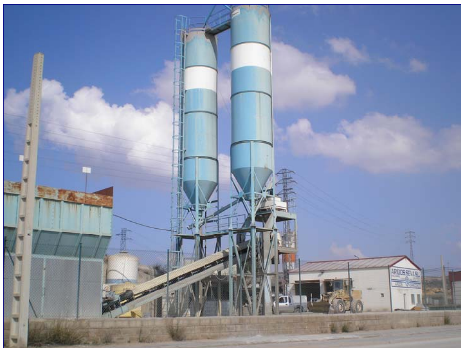
Fig. 4.8.- Instalaciones para preparación de hormigones. Arriba: Montes de Torrero (Zaragoza). Abajo: Andorra (Teruel)
