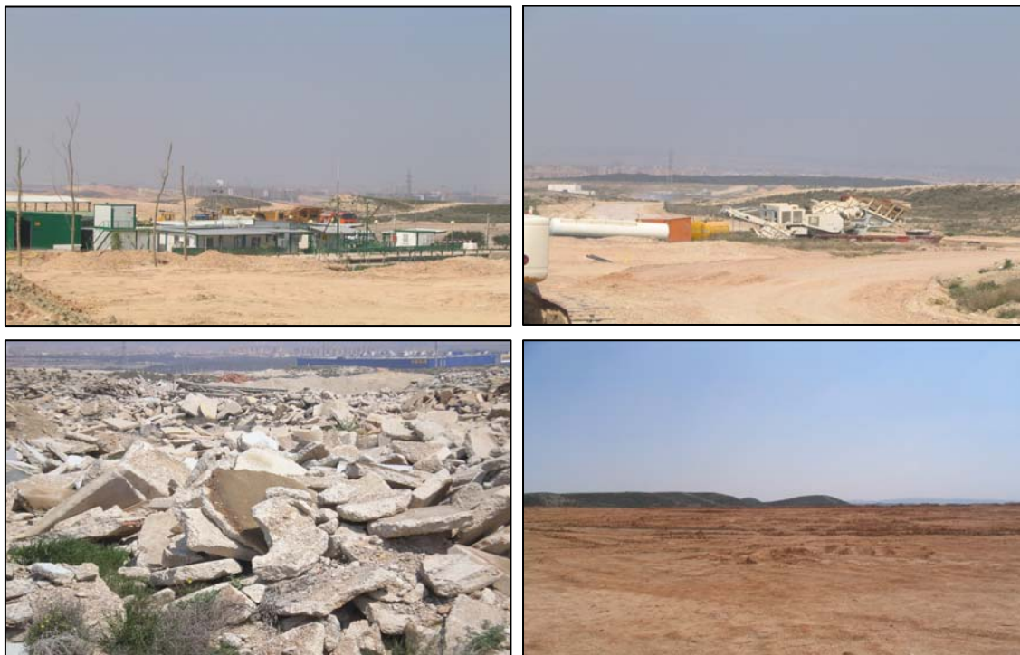
Fig.- 5.35.- Vertedero autorizado de RCD's "Las Canteras" en Torrero, Zaragoza. (Instalaciones, planta móvil de machaqueo, escombros y sellado del vertedero)
