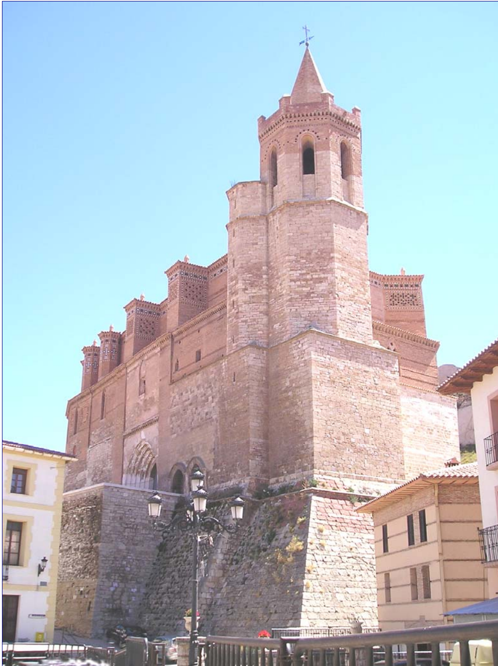
Iglesia de Santiago Apóstol (siglos XIII-XIV) en Montalbán, Comarca de Cuencas Mineras. Construida con piedra sillar caliza (estilo Gótico) y con remate superior en ladrillo (estilo Mudéjar). Foto: J. A. Soriano Sanz.
