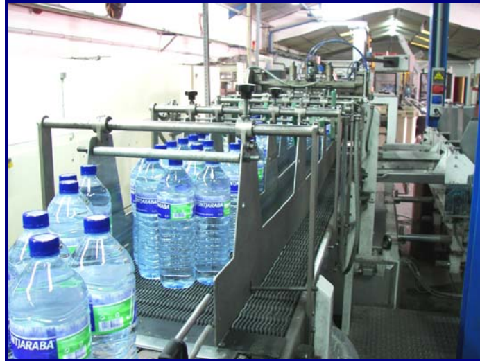
Fig. 3.42.- Instalaciones (planta de Fontjaraba)
