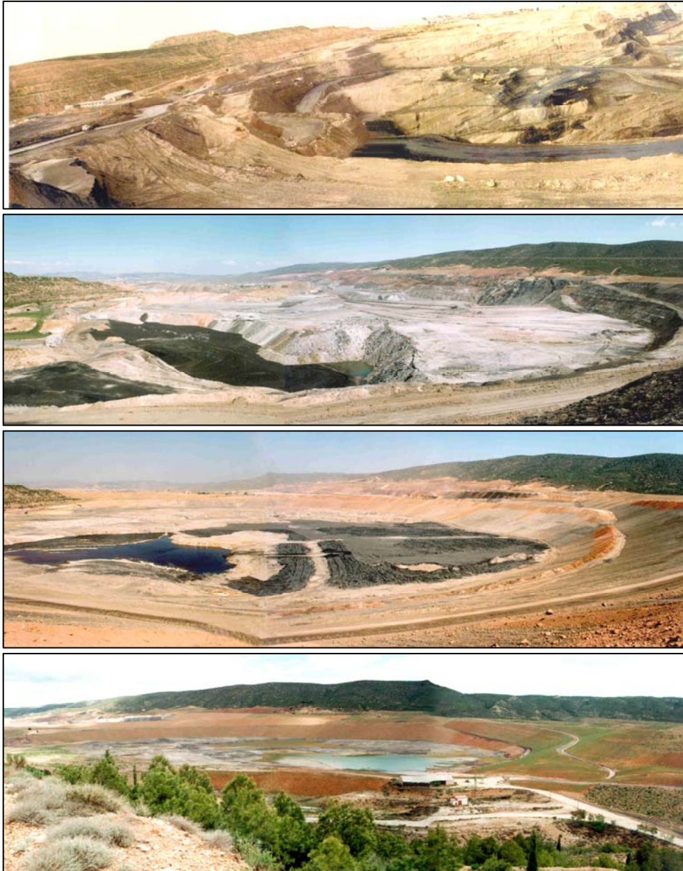
Fig. 5.36.- Creación de un humedal en el hueco final de la Corta de Alloza (Fotos: ENDESA GENERACIÓN, SA).
