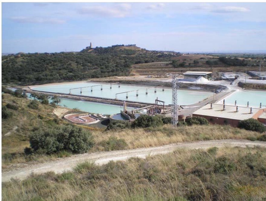
Fig. 3.12.- Complejo industrial para producción de sal por disolución en profundidad. Castejón del Puente, Huesca. SALES DE MONZÓN, S.A.
