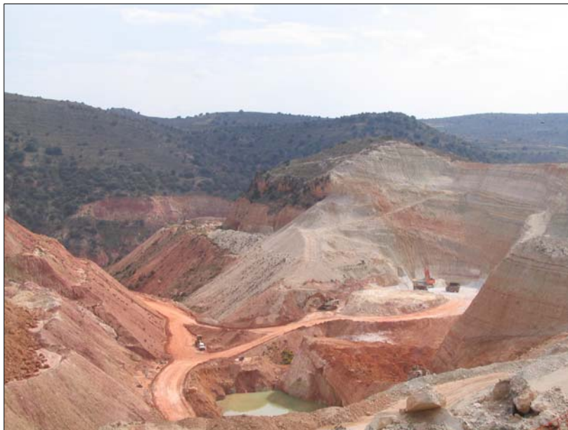
Fig. 5.14.- Modificación de la red de drenaje y generación de sólidos en suspensión
