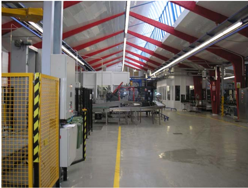
Fig. 3.57.- Instalaciones de la planta Vilas del Turbón
