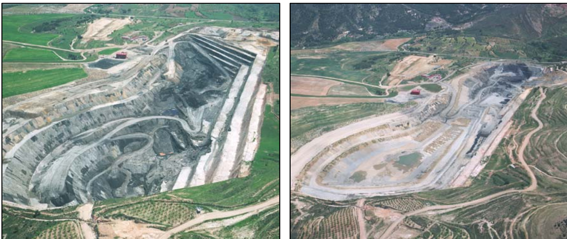
Fig. 5.41.- Corta Gargallo. Proceso de relleno del hueco final (Fotos: ENDESA GENERACIÓN, S.A.)
