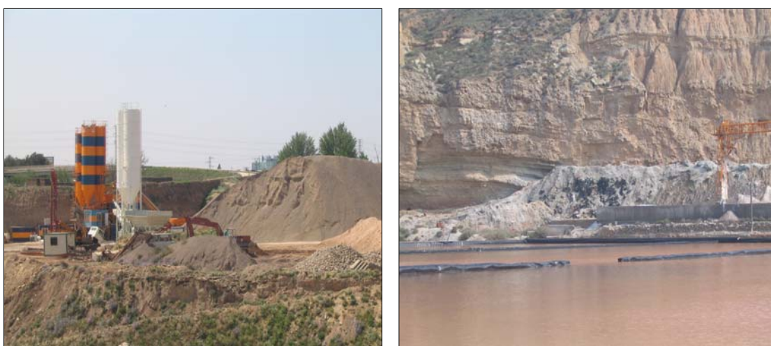
Fig. 5.16.- Izq.: Instalación móvil de fabricación de hormigón en hueco de socavación de una gravera. Dcha.: Salinas en el término de Remolinos, Zaragoza
