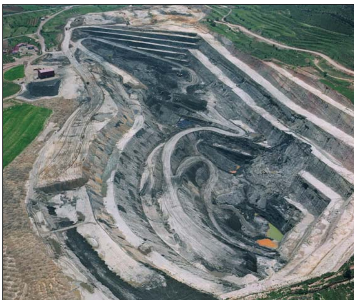
Fig. 5.15.- Drenajes ácidos y precipitados de hidróxidos en fondo de corta
