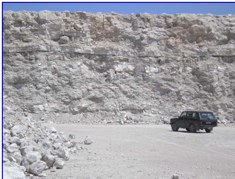
Fig. 3.10.- Dos aspectos de frente de cantera de yeso en explotación. Pina de Ebro, Zaragoza. EYESEBRO, S.L.
