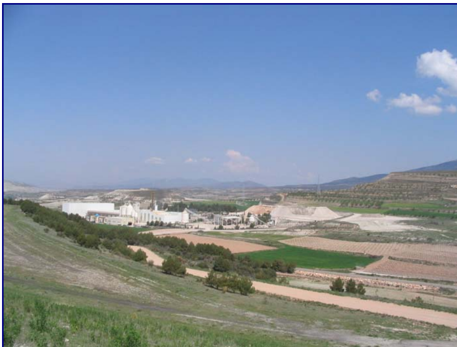
Fig. 4.14. Planta de tratamiento de sepiolita en Osera (Zaragoza). Pág. siguiente: Acopios de mineral a pie de planta. MYTA, S.A.
