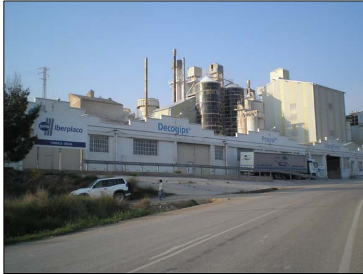
Fig. 4.2.- Fábrica de placas de yeso. IBERPLACO
